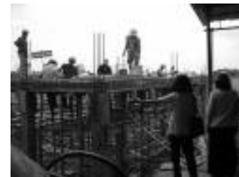
(東北電力のボランティア有志が支援し、建設中の小学校)
